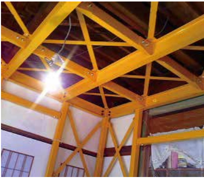
一部屋に鉄筋を組み込むことで強い住まいに変身させる
