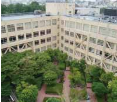
同社が手掛けた上智大学耐震工事
