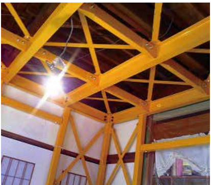
一部屋に鉄筋を組み込むことで強い住まいに変身させる
