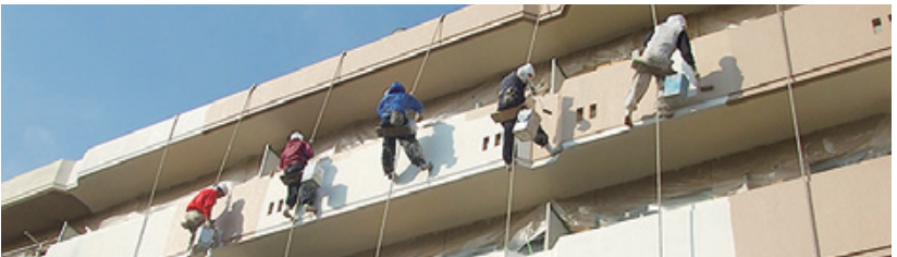
コストダウンなどさまざまなメリットがある「無足場工法」
