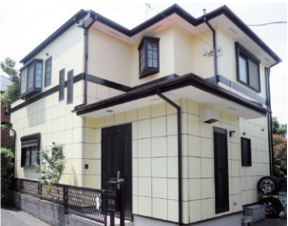
外壁塗装の施工後
