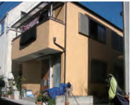
同社施工事例
