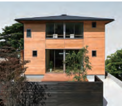
「あたらしい家「校倉」」では、外壁に国産の杉材を厚さ30mm使用し施工
