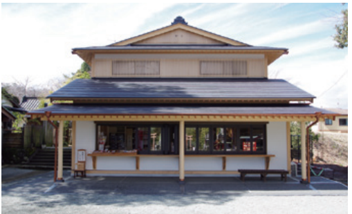
施工したての白笹稲荷神社社務所
