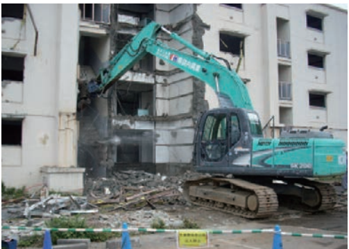
解体工事現場
