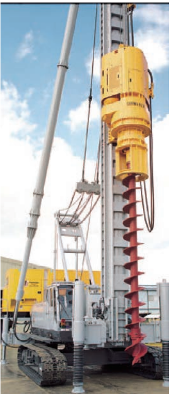
工事現場のロックオーガー (SMD-150HP)
