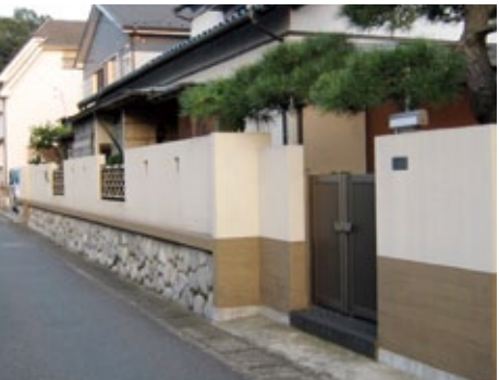
EPS工法の施工事例(見た目は完全に重たいブロック塀!?)
