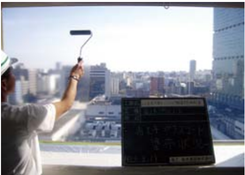
「省エネガラスコート」の施工例
