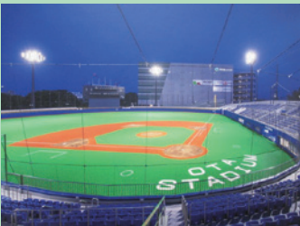
大田スタジアム 改修工事(2019年6月)
