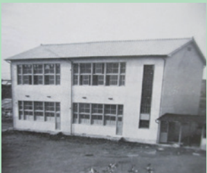
大田区立矢口中学校 新築工事(1951年1月)
