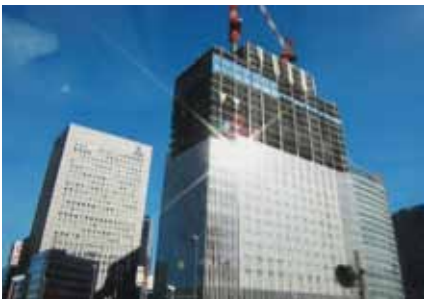
同社の施工現場の一つである横浜三井ビルディング
