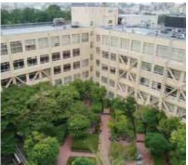
同社が手掛けた上智大学耐震工事
