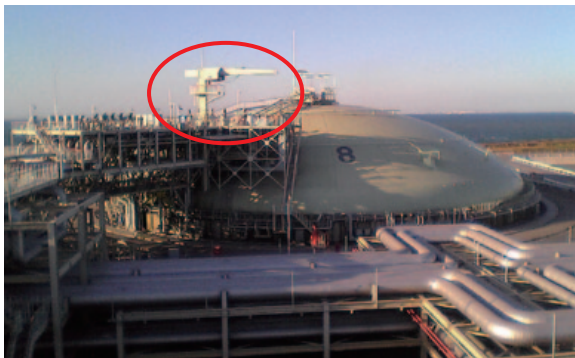
千葉県袖ヶ浦のLNGタンク ○囲みのクレーンが同社製品(ジブクレーン:固定式)
