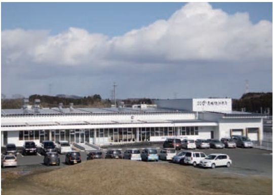
フル稼働をめざす東松島市の新工場
