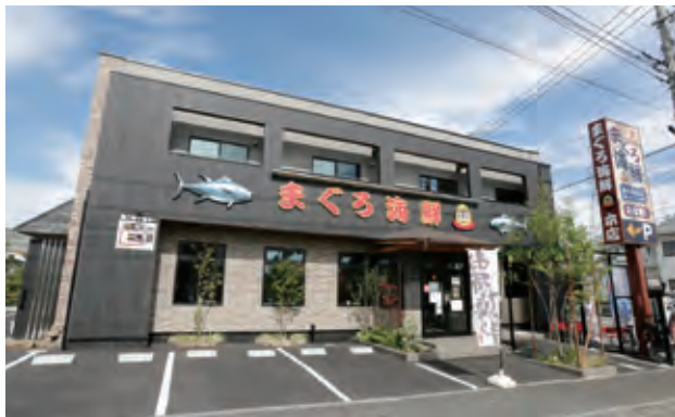
建築板金工事を営む同社施工の店舗外観
