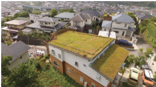
草屋根工法:木造家屋の屋根を緑化する工法の施工事例
