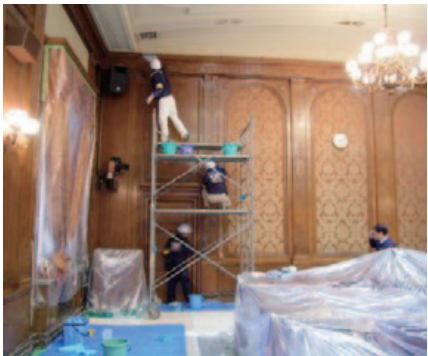
参議院第一議員会議室檜壁洗浄工事の様様
