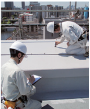
施工現場の作業風景
