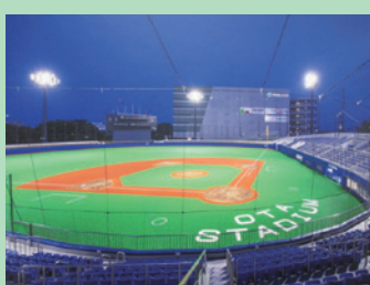
大田スタジアム 改修工事(2019年6月)
