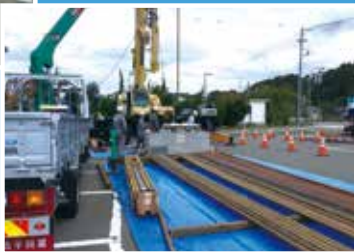
温泉井戸現場に水位センサを設置する作業
