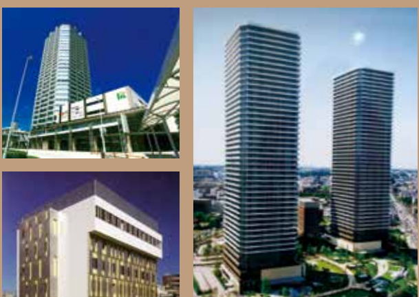
同社の手がけた施工事例
