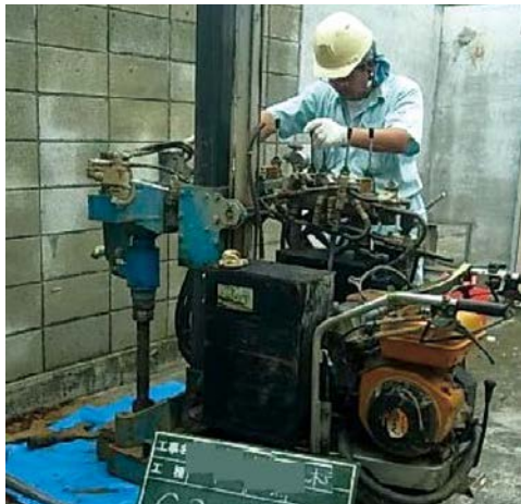
ボーリング調査での土壌試料採取の様子（自社製造機による掘削）
