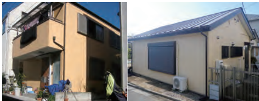
同社施工事例
