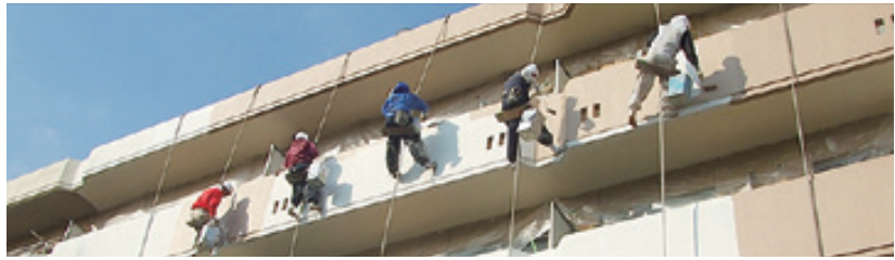
コストダウンなどさまざまなメリットがある「無足場工法」
