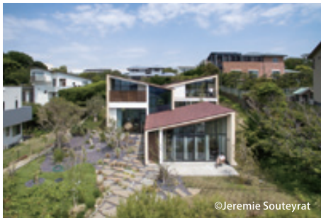
披露山公園での新築工事
