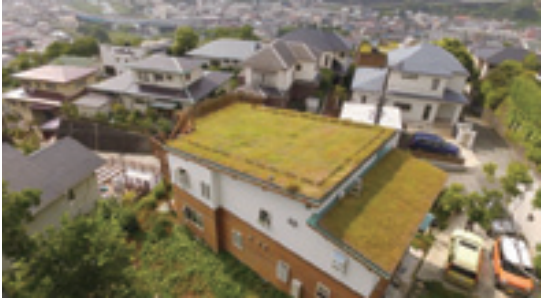
草屋根工法:木造家屋の屋根を緑化する工法の施工事例
