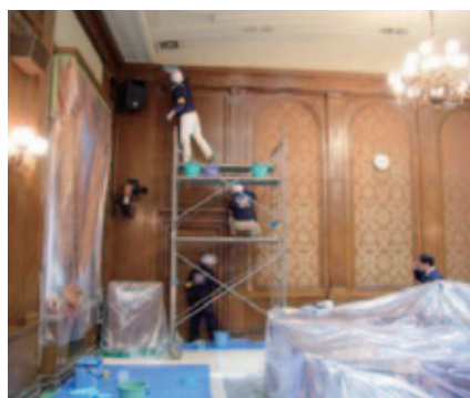
参議院第一議員会議室檜壁洗浄工事の様相
