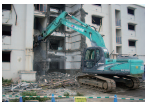
解体工事現場
