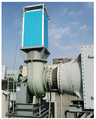
工場用ダクトの防音施工例
