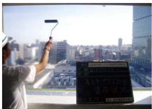
「省エネガラスコート」の施工例
