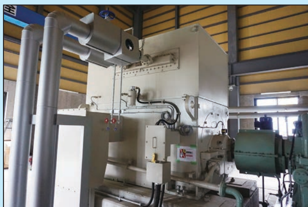
<蒸気タービンの回転エネルギーで電気を発生>
