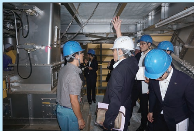
<ボイラー棟内での説明>
