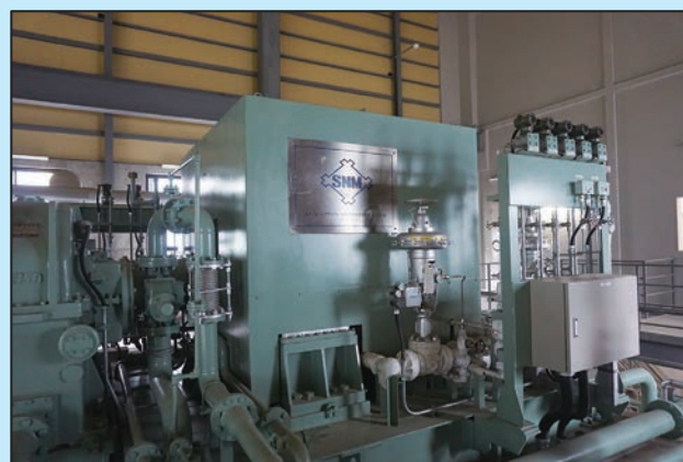
<蒸気を利用してタービンを駆動>
