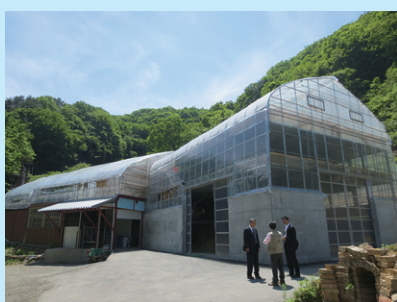
<木質バイオマス発電所>
